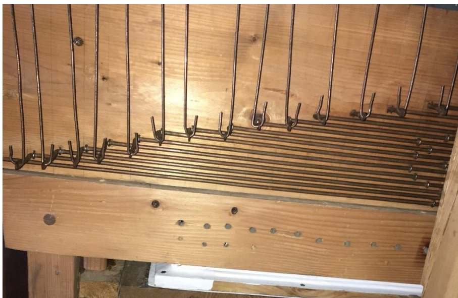
La catenacciatura del somiere maestro dopo il restauro
