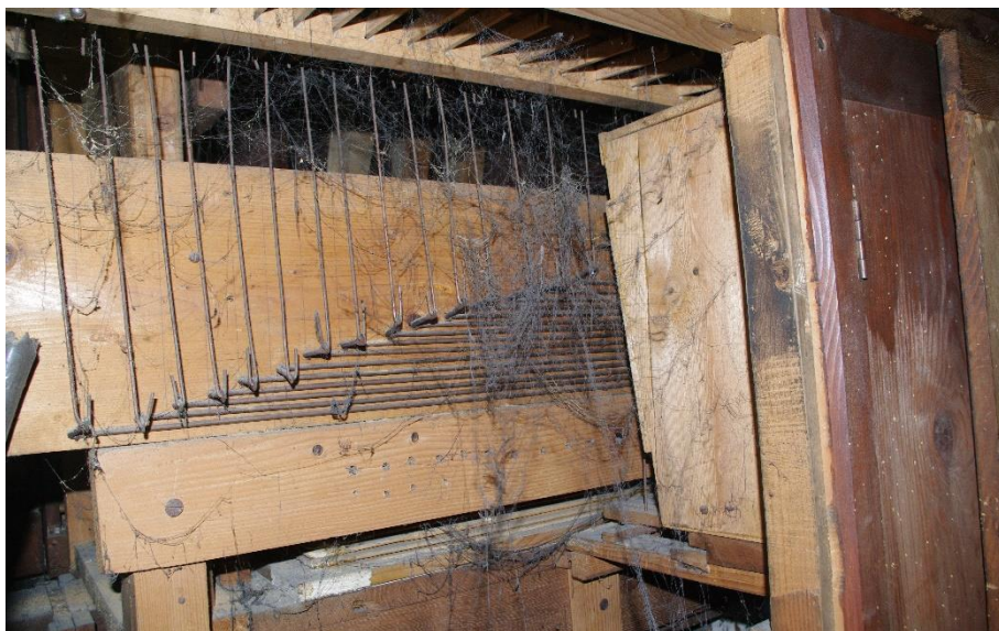
La catenacciatura del somiere maestro prima del restauro
